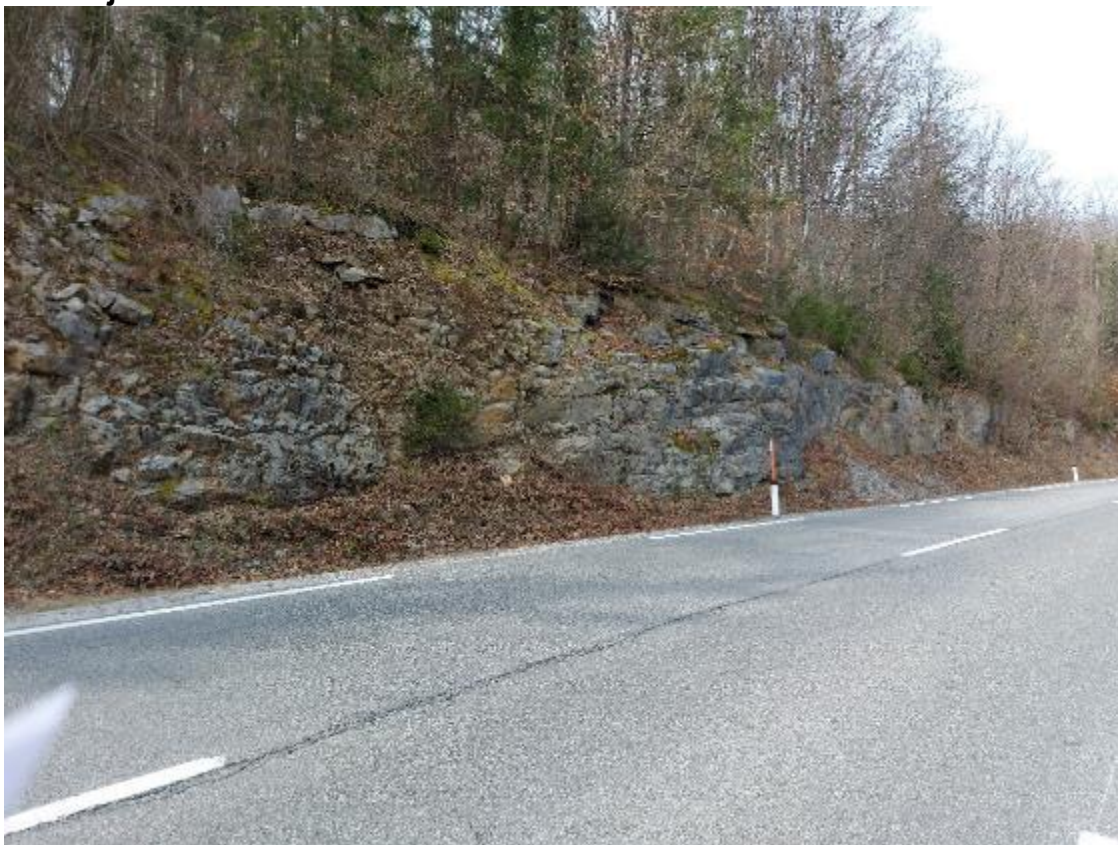
Lokacija 3: od km 10.688 do km 11.030
