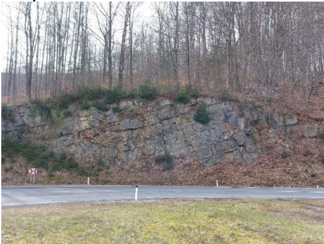
Lokacija 5: od km 11.189 do km 11.231
