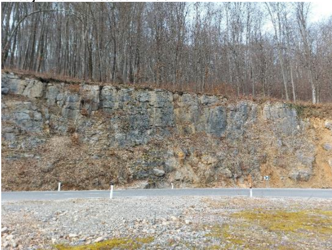
Lokacija 2: od km 10.550 do km 10.627
