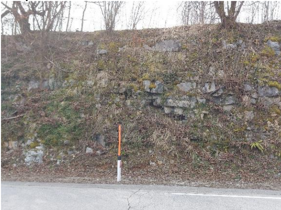
Lokacija 6: od km 13.631 do km 13.708
