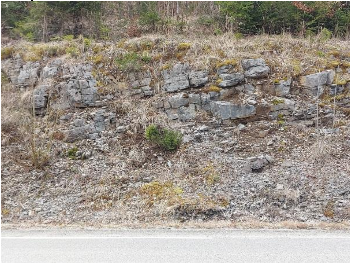
Lokacija 4: od km 11.068 do km 11.162
