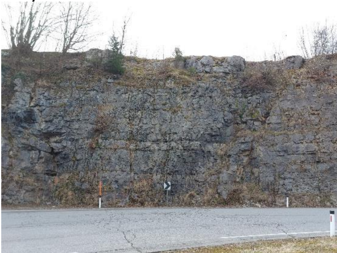
Lokacija 7: od km 13.708 do km 13.820
